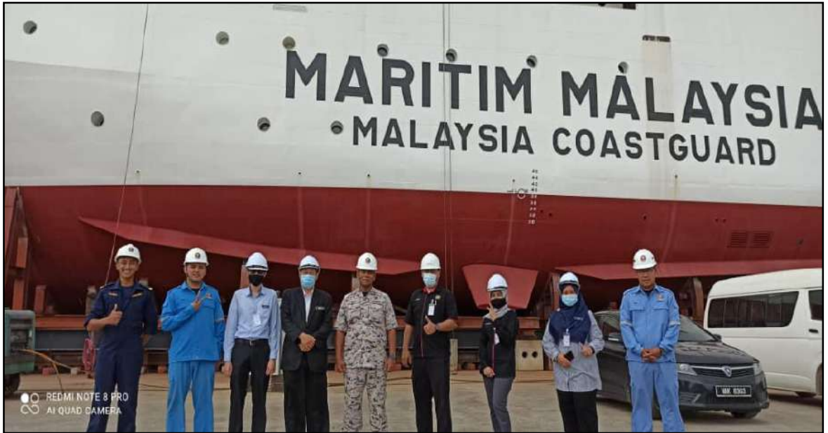
Lawatan Ketua Audit Dalam dan Pasukan Audit Terhadap Pembinaan Offshore Patrol Vessel (OPV) APMM Pulau Indah Industrial Park, Selangor (10.12.2020)
